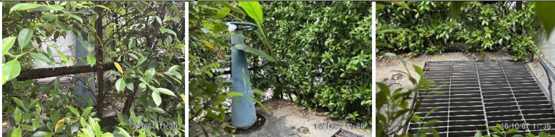
รูปที่ ผ7.11 ตะแกรงดักมูลฝอย
